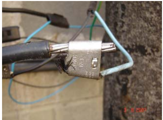
Conector protegido com CorrosionX
