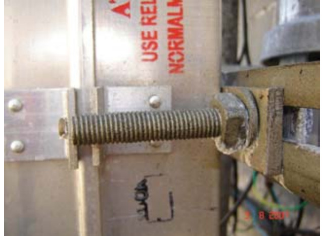
Parafuso protegido com CorrosionX
